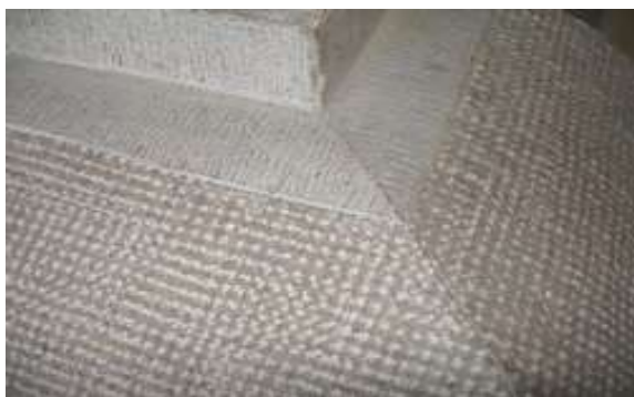
Finition bouchardée du béton
